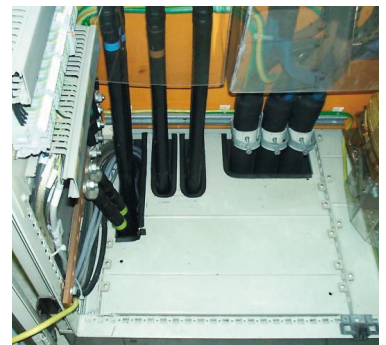
Bild 2. Induktionseffekte bei Einzeladerverlegung können zu einem Überhitzungsproblem werden
