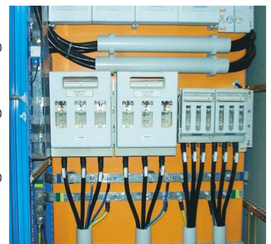
Bild 1. Überhitzte Kabelanschlüsse, mit dem normalen Auge nicht erkennbar (rechts), führen schnell zu einem Anlagenstillstand
