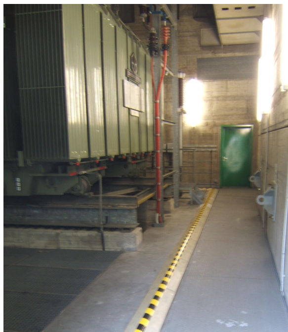
Bild 1: Blick auf den Transformator mit Stauschwelle im Innenbereich
