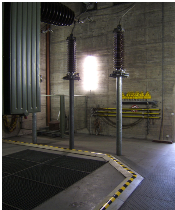
Bild 1: Blick auf den Transformator mit Stauschwelle im Innenbereich
