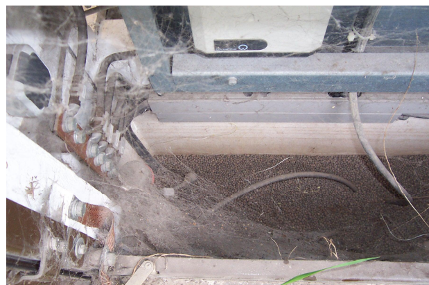
Bilder einer schlecht gewarteten Kompaktstation
