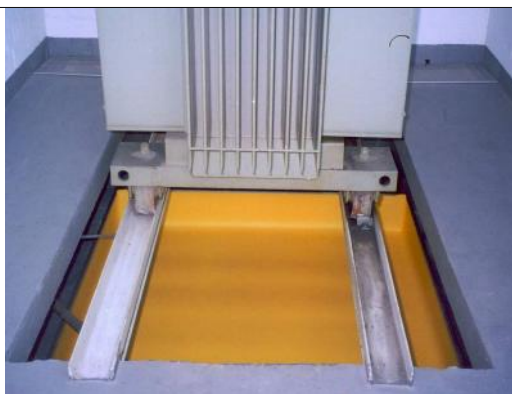
Typ 2: Boden ist eben und Raum viel größer als Abmessung Trafo
