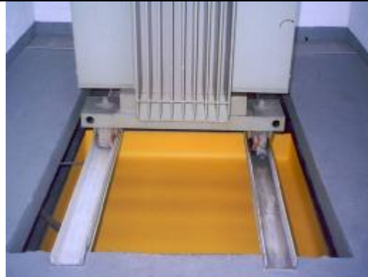
Typ 2: Boden ist eben und Raum viel größer als Abmessung Trafo
