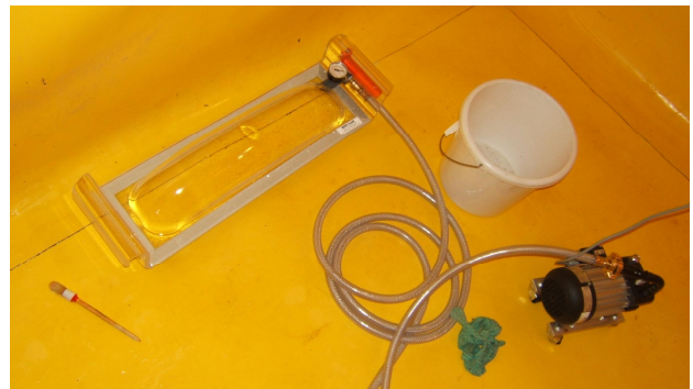
Prüfung der Ölwanne eines Transformators
