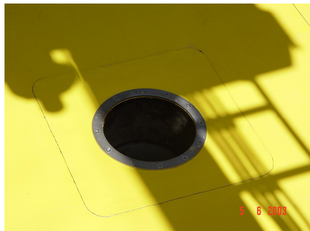
Ölaufangwanne eines Leistungstransformators mit Ablauf
